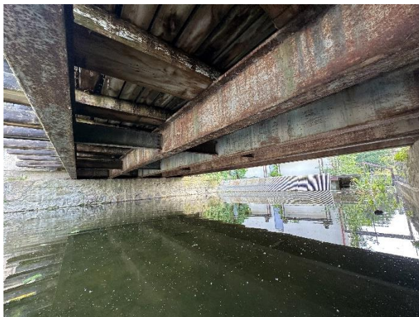
Zdj. 6 Korozja powierzchniowa stalowych dźwigarów.
