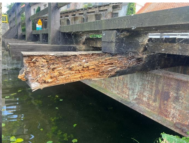
Zdj. 9 Ubytki w skorodowanej drewnianej poprzecznicy pomostu.
