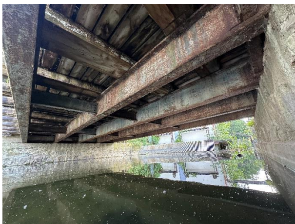
Zdj. 8 Korozja i ubytki w drewnianych elementach pomostu.
