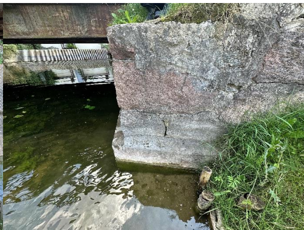
Zdj. 11 Ubytki spoin, wegetacja roślin na kamiennych przyczółkach.
