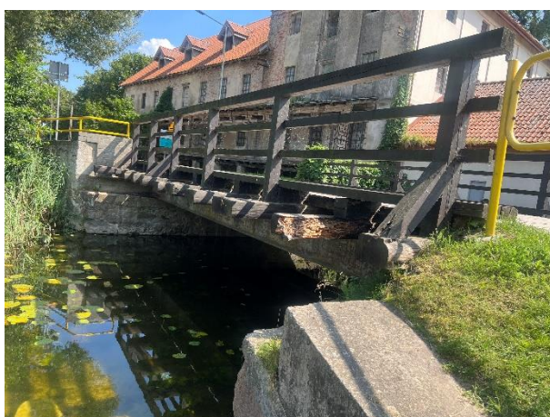
Zdj. 14 Ubytki i zarysowania balustrady.
