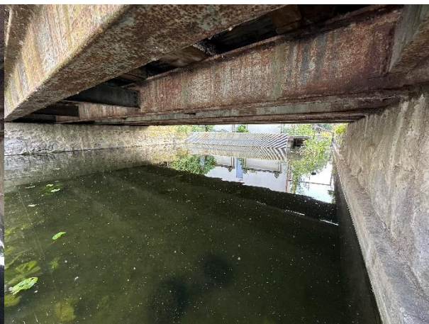
Zdj. 7 Korozja powierzchniowa stalowych dźwigarów.
