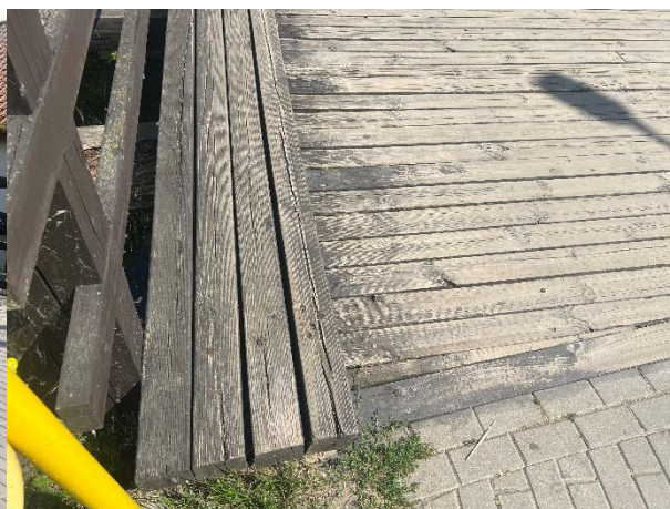
Zdj. 13 Pęknięcia i zarysowania drewnianego chodnika, brak powłok antykorozyjnych.
